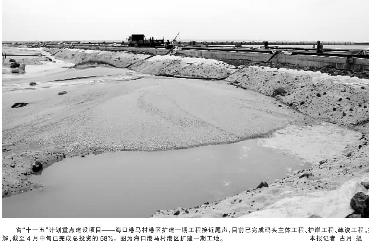
省“十一五”计划重点建设项目——海口港马村港区扩建一期工程接近尾声,目前已完成码头主体工程、护岸工程、疏浚工程。据了解,截至4月中旬已完成总投资的58%。图为海口港马村港区扩建一期工地。本报记者 古月 摄
