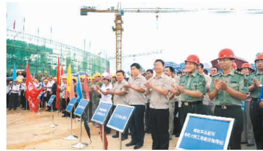
位于三亚海棠湾的解放军总医院海南分院目前正在加紧建设中,施工现场有3000多名工程技术人员和工人日夜奋战。4月27日上午,解放军总医院海南分院各参建单位冒雨参加分院工程建设会战誓师大会,誓把分院建成良心工程、放心工程、满意工程。本报记者 苏建强 摄
