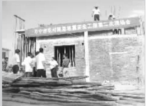
万宁农村民居地震安全工程第二次现场会
