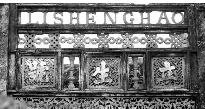
复兴街骑楼立面图案丰富多彩,“立生号”三个字清晰可见。
