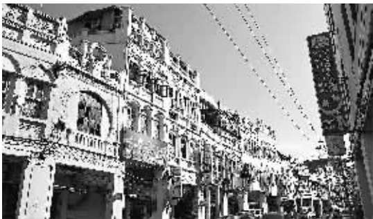
海南骑楼,契合海南的地理、气候,是适应本土文化的建筑典范。 李幸璜 摄
