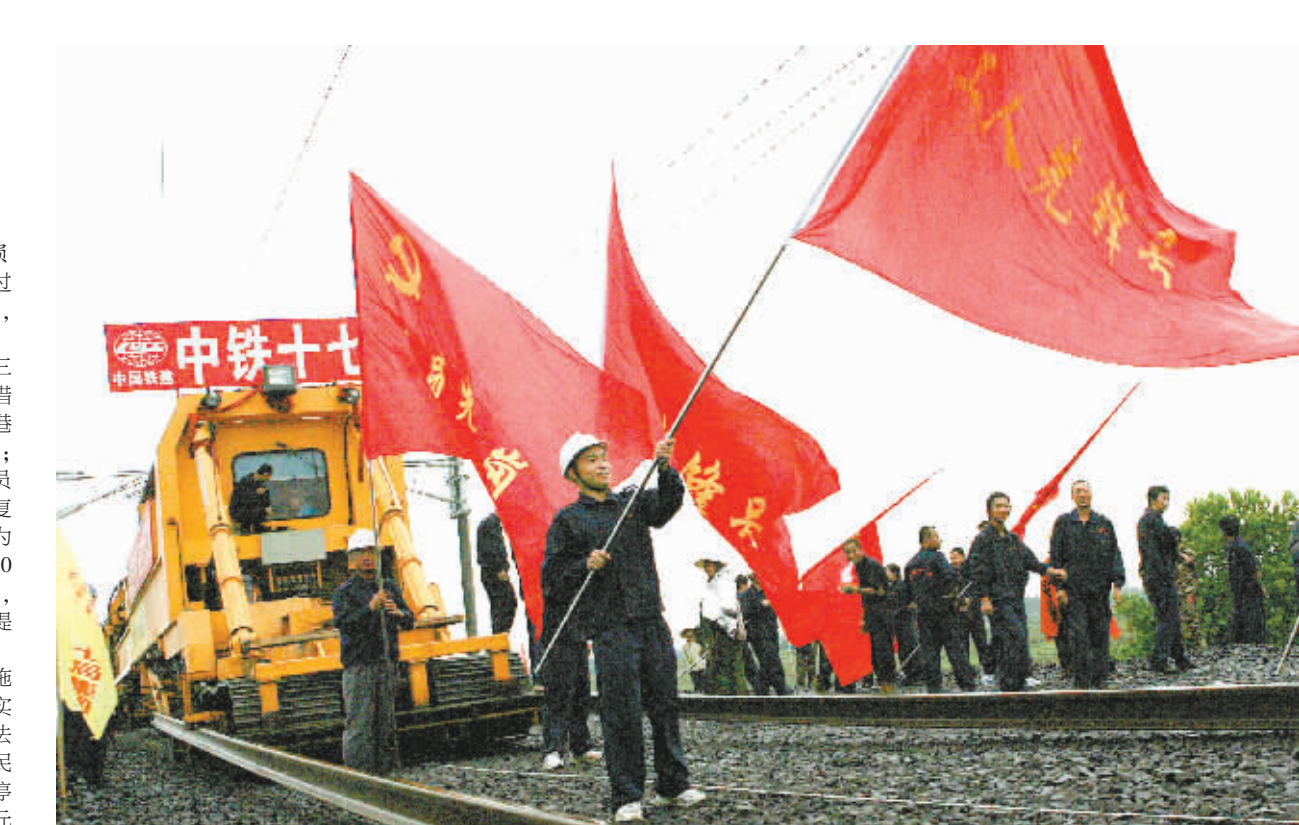
5月31日下午5时,中铁17局海南铺架队工人冒雨铺设完最后一段铁轨。至此,由该局承担的东环铁路北段暨海口至博鳌分界点铺轨任务完成,为东环铁路全线贯通奠定了坚实基础。 本报记者 古月 摄
