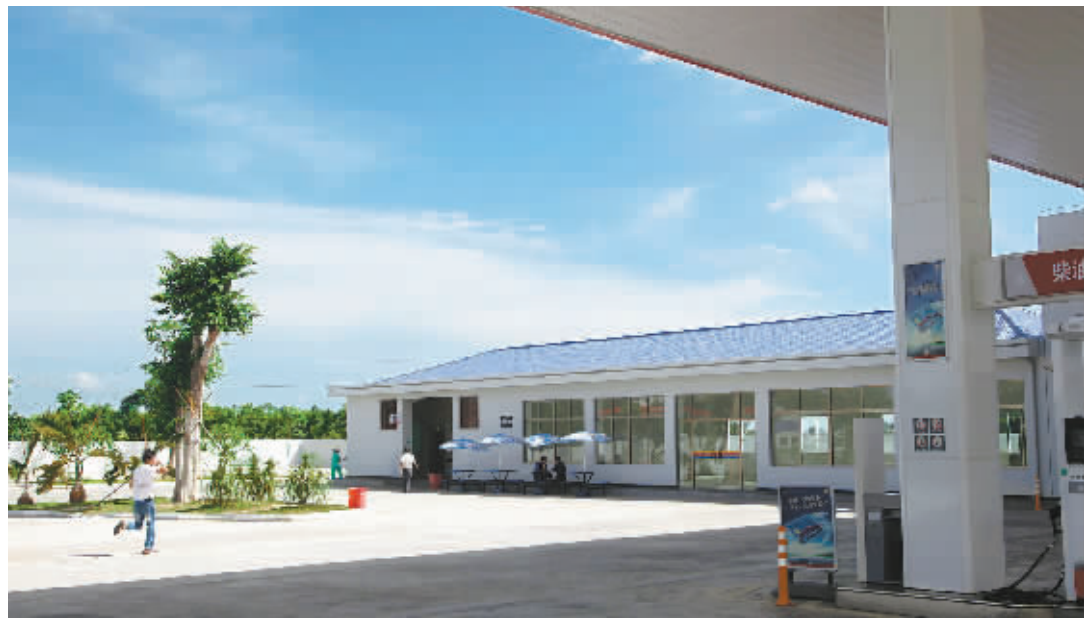
东线高速公路中原服务区加油站注重环境建设,给司机和乘客提供了一个整洁、美观、舒适的临时休息场所。本报记者 苏晓杰 摄
