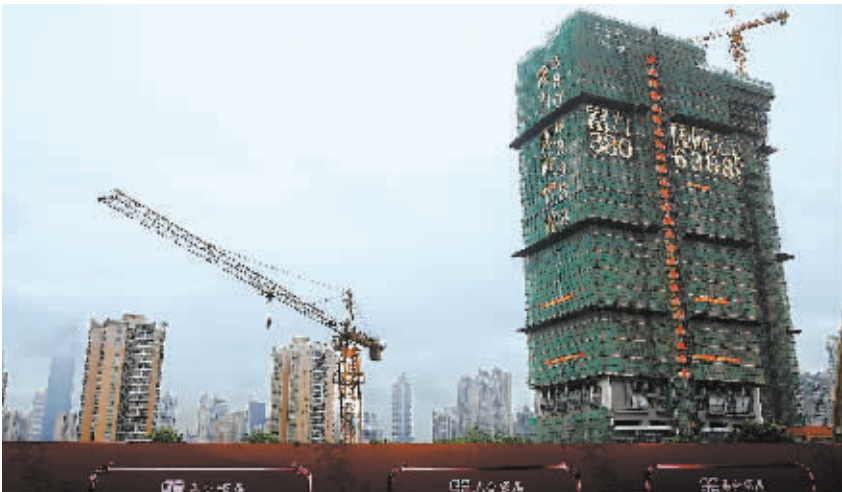
广州5月份楼市成交低迷，据统计，广州5月份共计在售楼盘469个，其中有网签成交记录的楼盘243个，约近半楼盘零成交。
