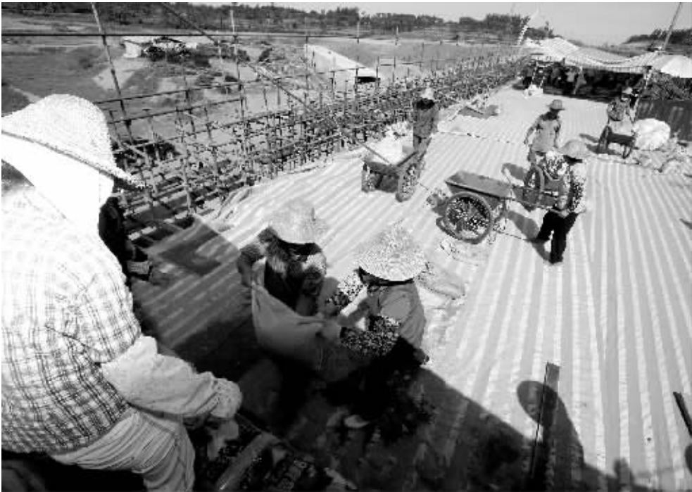
7月7日,在海口至屯昌高速公路施工现场,工人们冒着烈日加紧施工,目前该工程施工进展顺利,建设提速。据了解,海口至屯昌高速公路是我省重点建设项目,全长 72.025 公里。截至目前,该项目已完成前期工作及征地拆迁工作拨款共计 3.52 亿元。部分路段已开始施工。 本报记者 张杰 摄
