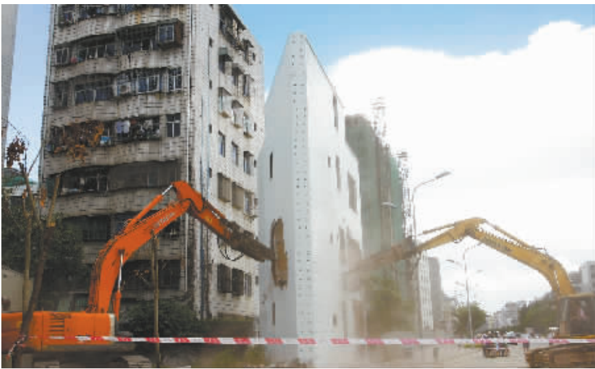
两辆挖掘机正在拆除“楼薄薄”。
