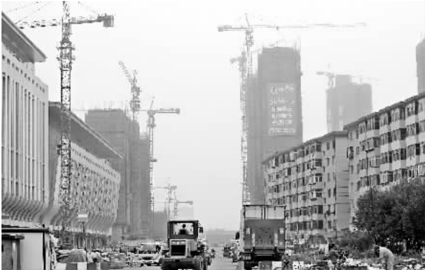
↑ 沈阳一处在建新楼盘 (7月10日摄)。 新华社记者 李钢 摄
