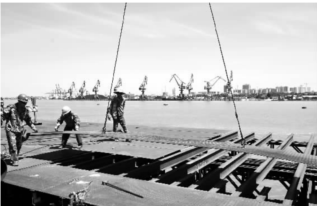
白马井—洋浦跨海大桥正在加紧施工。图为工人铺设桥墩平台。
