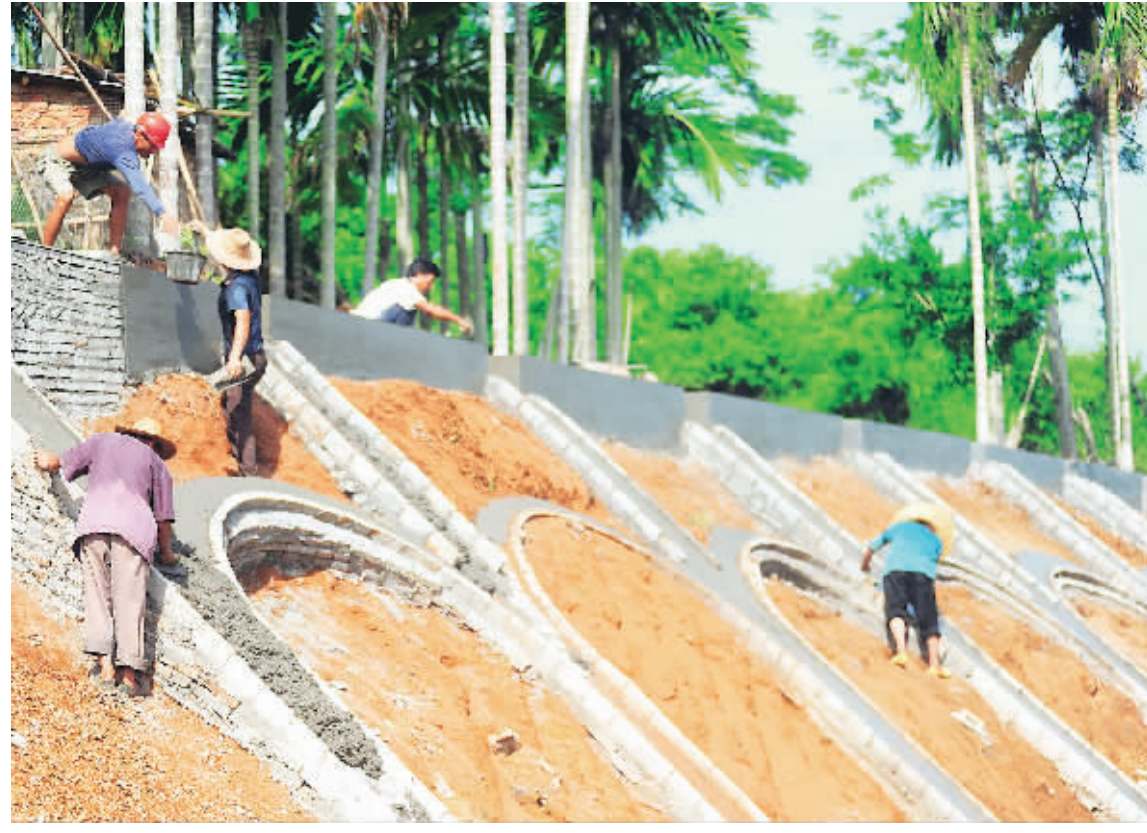
琼海建设东环铁路景观长廊
