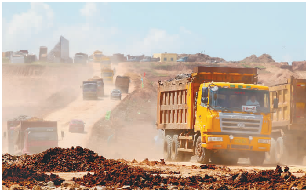
洋浦神头港区A区工地机械轰鸣,正夜以继日赶工期。 本报记者 苏晓杰 摄
