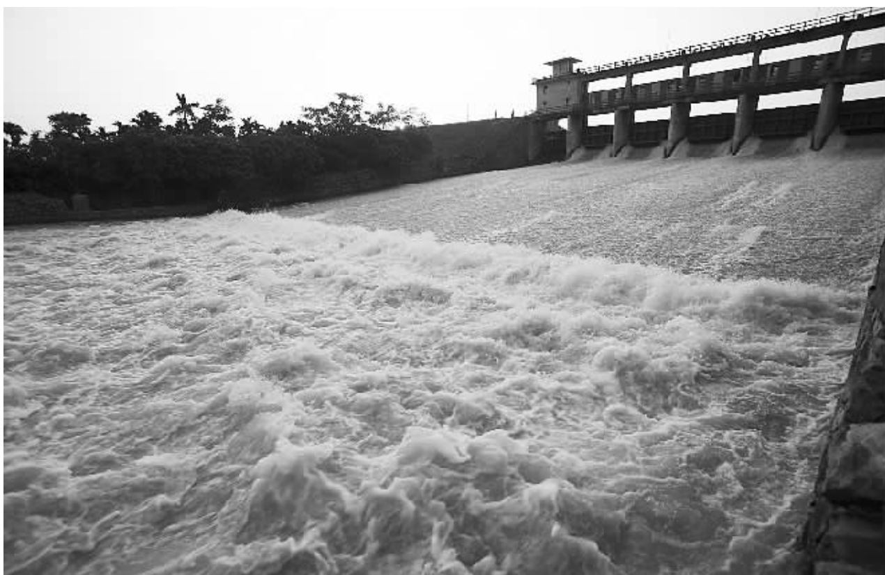
10 月 19 日，琼海市潭门镇合水水库为抵御超强台风“鲇鱼”的到来，正在按琼海市委、市政府的统一部署泄洪降低蓄水位。 本报记者 苏晓杰 摄
