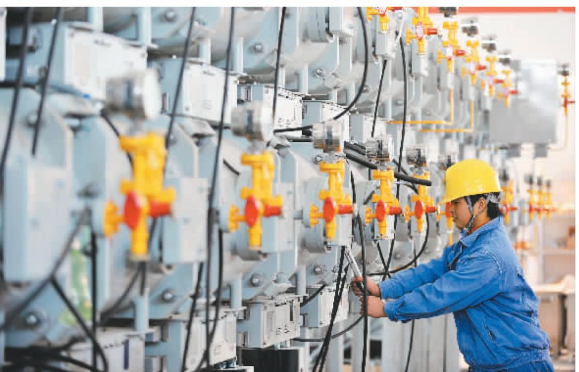
11月10日，在江苏无锡市前洲镇220千伏西泾输变电工程施工现场，电力职工在安装设备。
