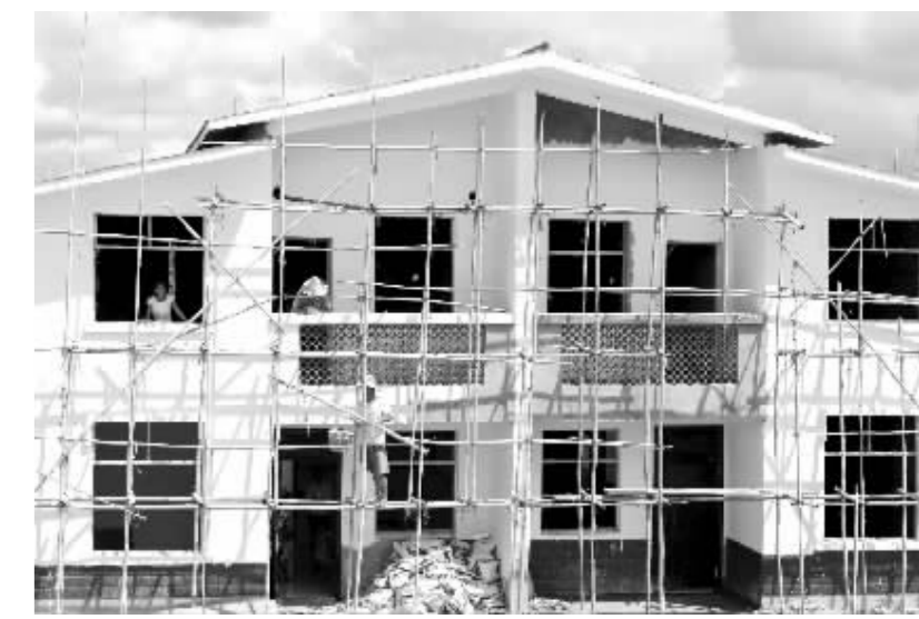
正在建设中的报白村新居。
