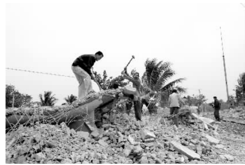
今年年初,工作人员在拆除危房。
