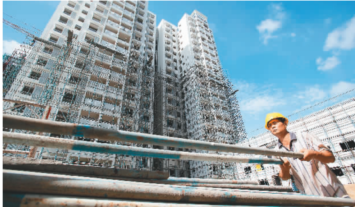
二〇一〇年八月十九日海口福秀小区廉租房建设工地上一派繁忙。本报记者 张杰 摄
