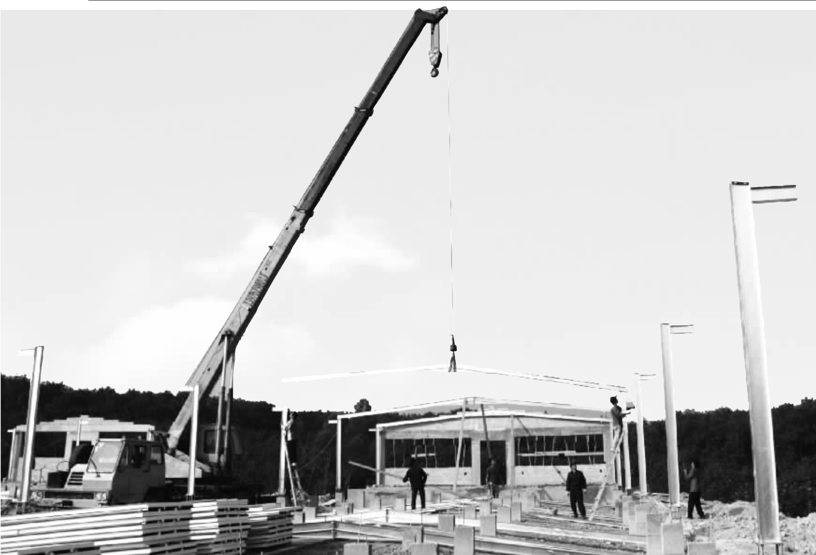
儋州鹏翔公司按欧美标准建设智能化养猪场
