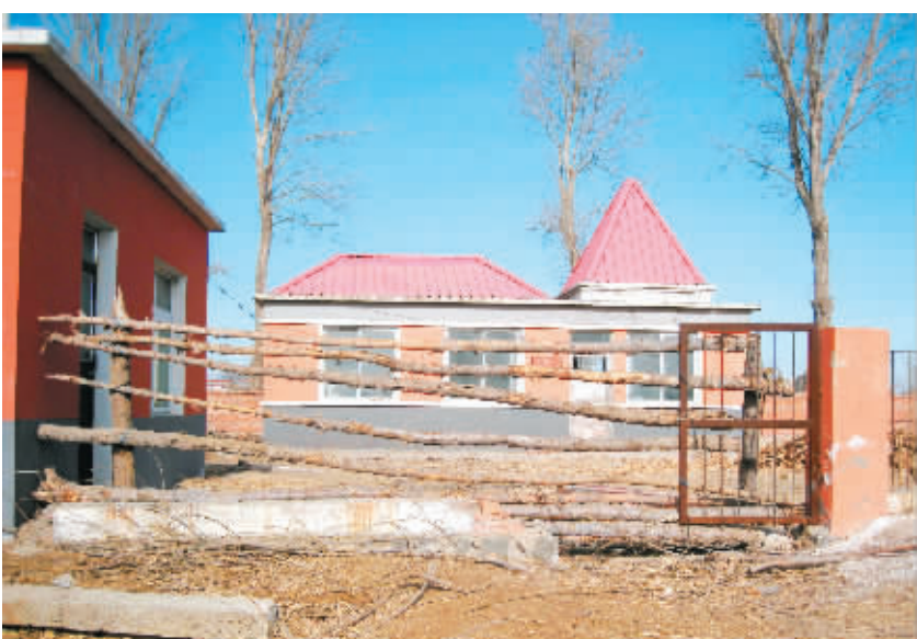
新民市卢屯乡卢屯村苏家窝堡的防氟改水工程泵房,建成于2004年,如今已经荒废。 新华社记者 汪伟 摄
