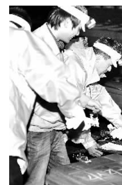
2月20日凌晨,东环高速铁路文昌段,工人们正在冒雨检查线路设备。本报记者 古月 摄
