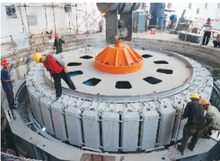
2009 年 10 月,技术人员在进行大广坝二期工程 2 号机安装施工。
