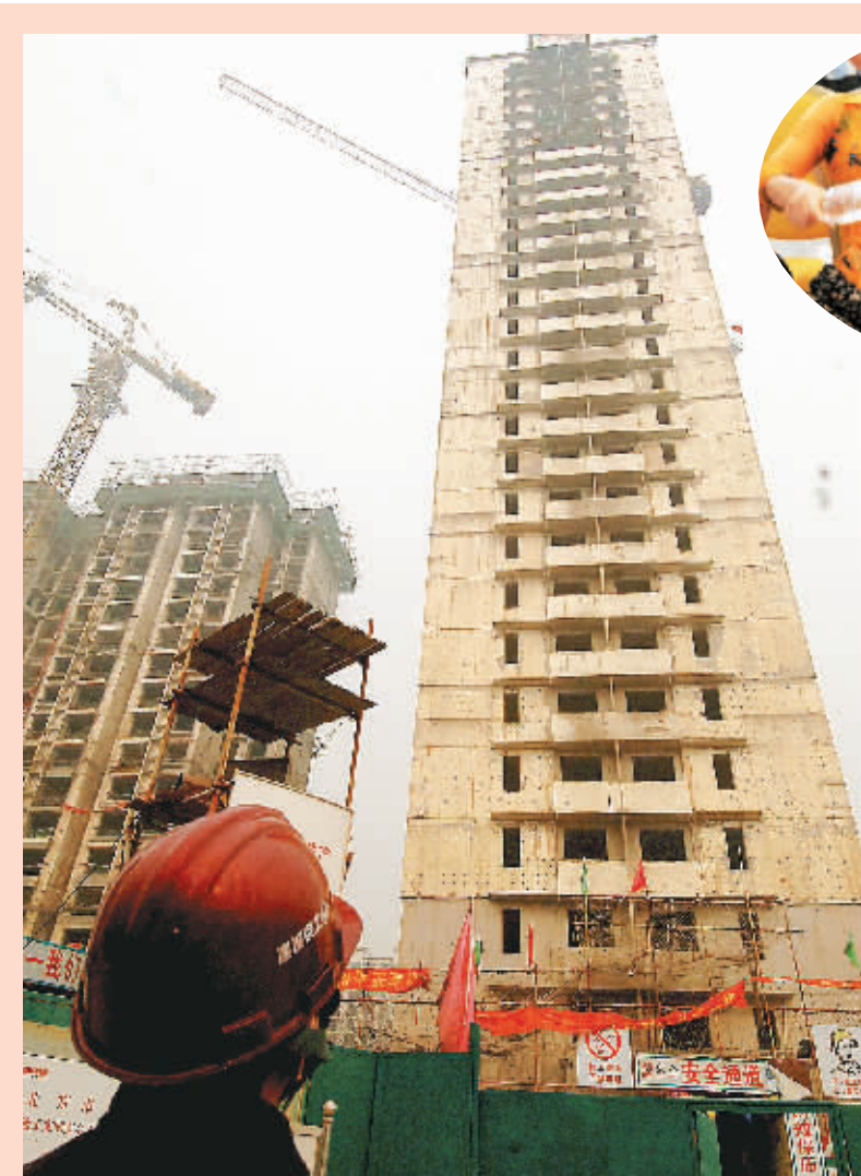
北京首个开工的公租房项目——北苑南区公共租赁住房项目封顶,500多套公租房将于年内摇号配租。(本版照片由新华社发)
