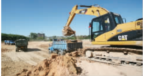
2010年6月开始，怡心花园小区保障性住房项目进行三通一平。
