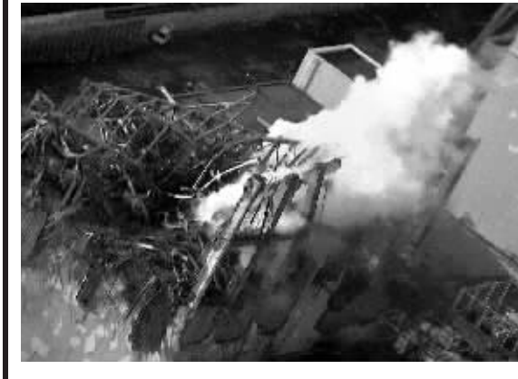
3月17日发布的日本福岛第一核电站3号机组的图片。
