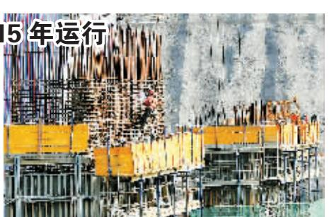
3月27日,三峡水利枢纽工程垂直升船机一期工程混凝土浇筑已达150米高程。三峡升船机主要用于为大型客轮提供一个“电梯式过坝”的快速通道,将成为三峡双线五级船闸“楼梯式过坝”的有效补充,大大提高船舶过坝效率。升船机将于2014年底建成试运行,2015年正式运行。新华社发
