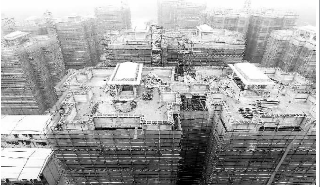
图为儋州市2010年500套廉租房建设项目,目前已进入初装修工程阶段,预计今年5月底全部交付使用。 本报记者 苏晓杰 摄
