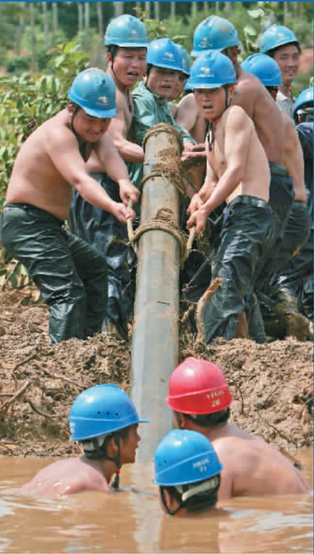
2010 年 10 月，海南电网全力抗洪抢险。图为供电抢修队在文昌会文镇给 10 千伏白延主线文林支线重新立杆。
