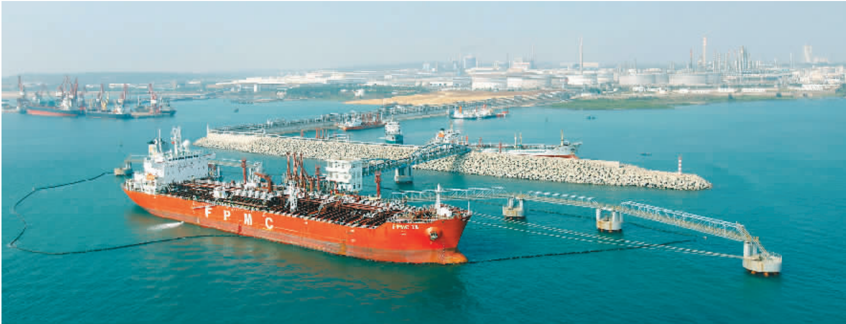
洋浦经济开发区已成为我省重要的能源输出基地。图为开发区内中石化海南炼油化工有限公司成品油码头。 本报记者 宋国强 摄
