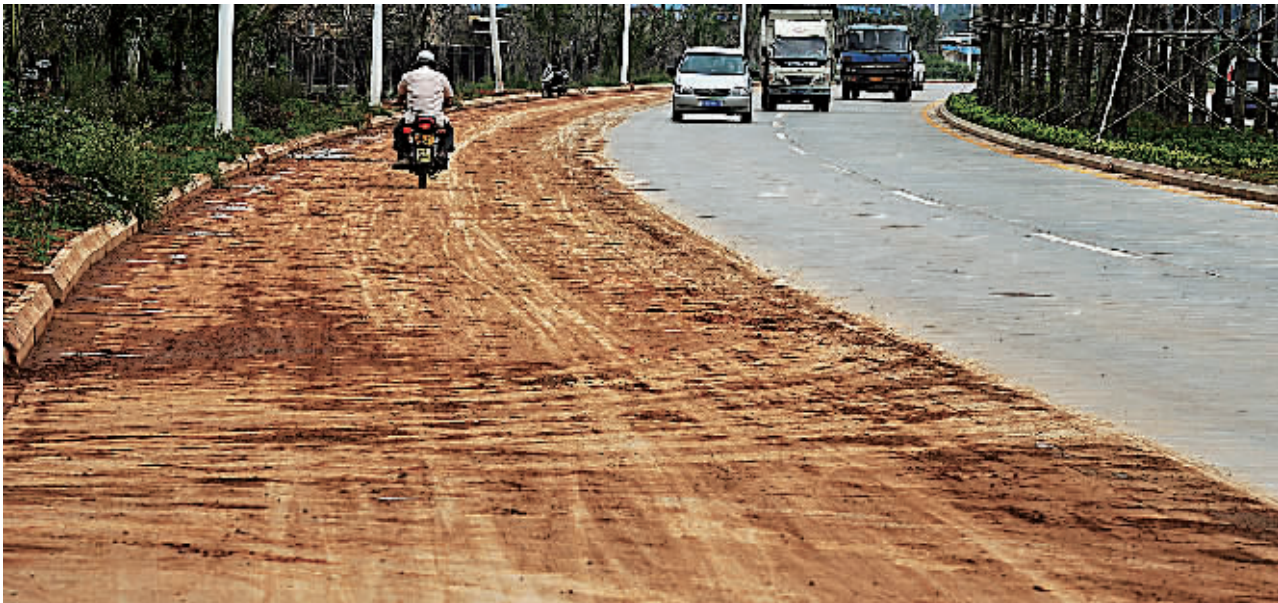
22日上午，海口丘海大道延长线一处工地出口路段被渣土车污染几百米。
