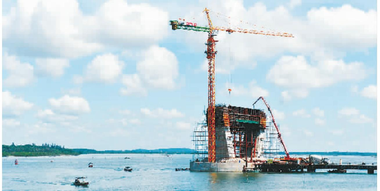
7月1日,作为文昌市未来发展大动脉之一的清澜大桥正在加紧施工,目前已完成工程量60%左右。其中,大桥西引桥钻孔桩已经全面完成72根,完成1956米;承台、墩身、钢梁制造、桥面板预制等建设进度顺利。
