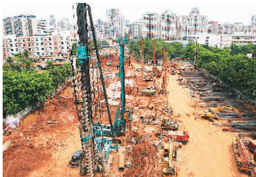
7月12日,海口市第一条公路隧道——侨中断路隧道施工现场一派繁忙景象。本报记者 古月 摄
