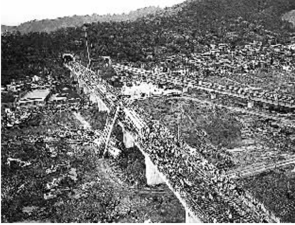
这是7月24日航拍的事故救援现场。 新华社发
