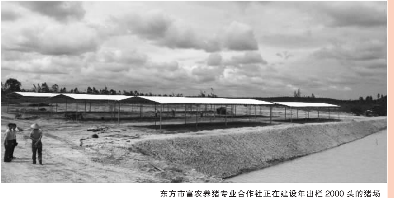
东方市富农养猪专业合作社正在建设年出栏2000头的猪场
