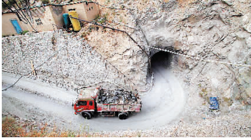
一辆卡车驶出贯通后的引水隧洞(8 月 28 日摄)。
