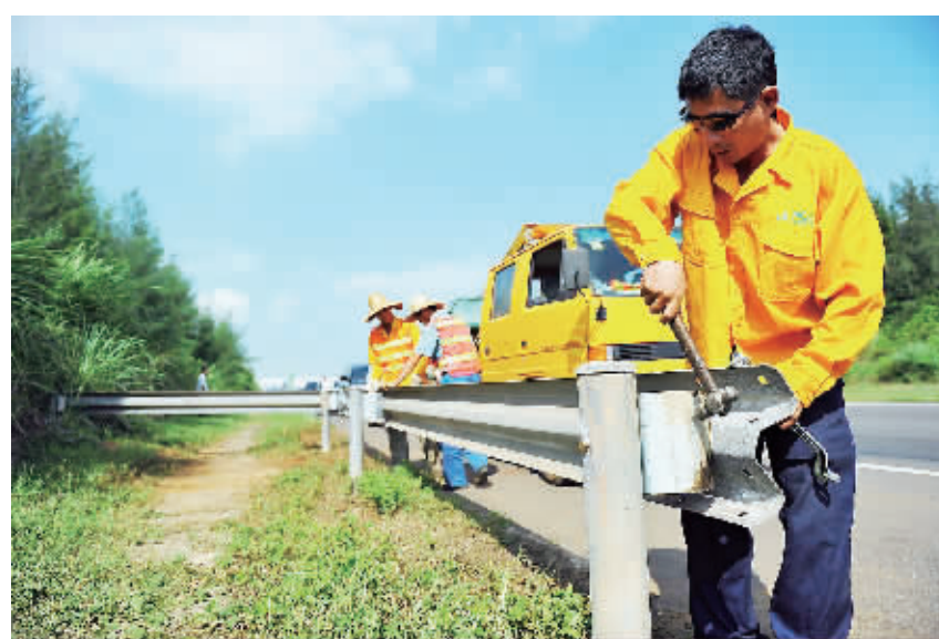
9月16日上午，在海口绕城高速公路整治现场，工作人员正在对非法开设道口、损坏的隔离栅和防撞护栏实施现场封闭和修复。
