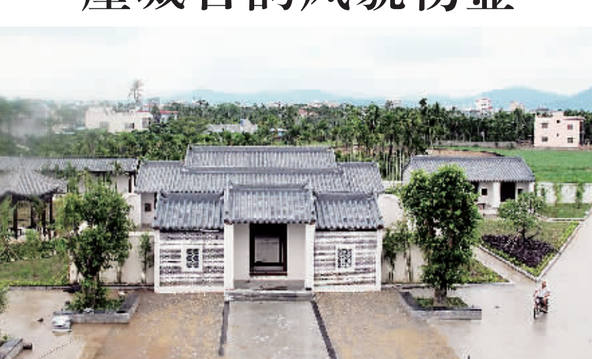
水南“盛德堂”修复工作已经进入室内装饰,不久将向游人开放。 本报记者 程范滢 摄
