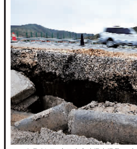
9月21日,在天定高速通安驿段,一辆汽车从出现路基沉降的路面旁驶过。
