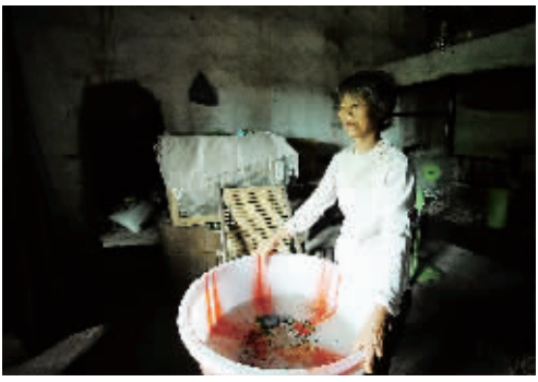
重庆市开县文峰街道高市村村民王学清在用盆接房顶漏下的雨水。
