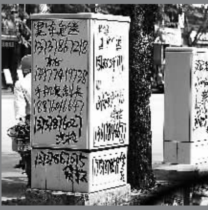
琼海人民路两个设备箱上涂满了“贷款”、“汽枪”、“黑车”等的违法诈骗电话号码。特约记者 蒙钟德 摄
