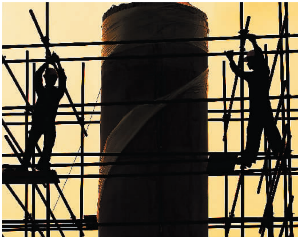
11月23日,万宁市兴隆旅游区,第十二届中国海南岛欢乐节主会场,工人们正在加紧施工。 本报记者 李英挺 摄
