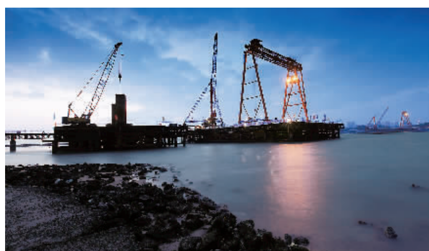
省重点建设项目儋州白马井—洋浦跨海大桥将于2013年5月建成通车,图为夜色中的大桥施工现场。
