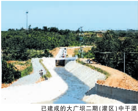
已建成的大广坝二期(灌区)中干渠
