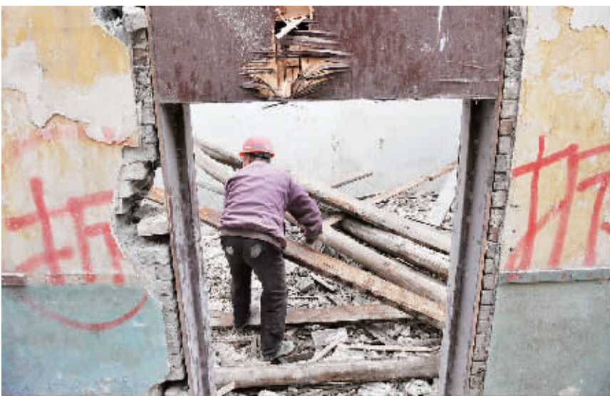
2月16日，一名工人在蒋介石“重庆行营”最后一层进行拆除作业。 新华社发
