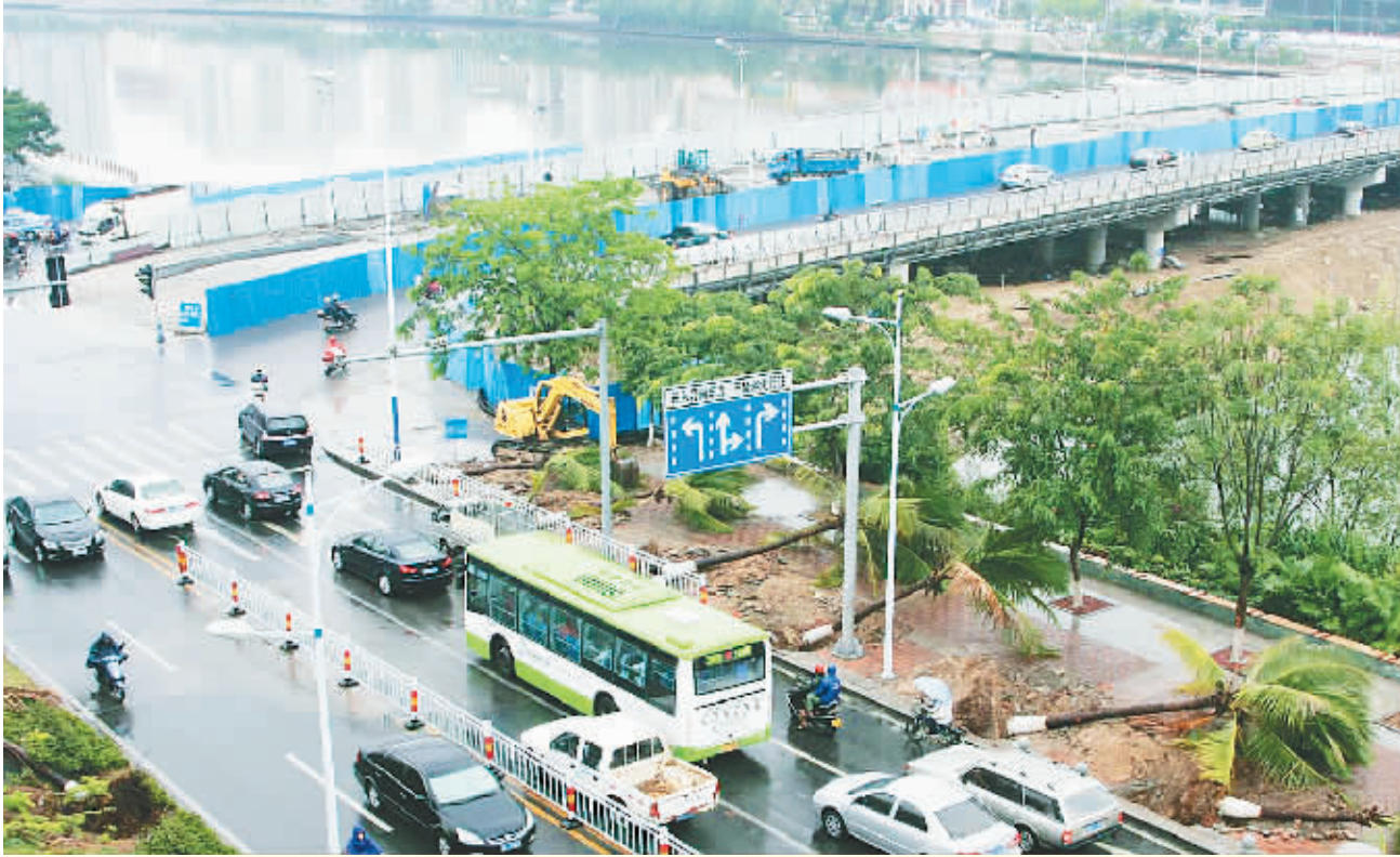
3 月 14 日，记者从三亚市交警部门了解到，重建的三亚市新凤大桥“三幅”桥面，将于 3 月底完工，4 月 1 日“三幅”新桥将并联并进行试通车。5 月 1 日新凤大桥将全线通车，新凤街交通拥堵状况，将得到缓解。 图为新凤桥左右中“三幅”桥面已合拢。 孙清 摄
