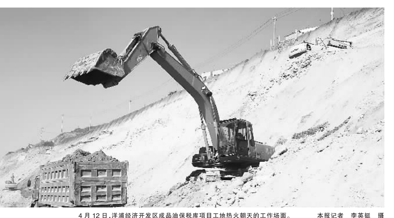
4月12日,洋浦经济开发区成品油保税库项目工地热火朝天的工作场面。 本报记者 李英挺 摄
