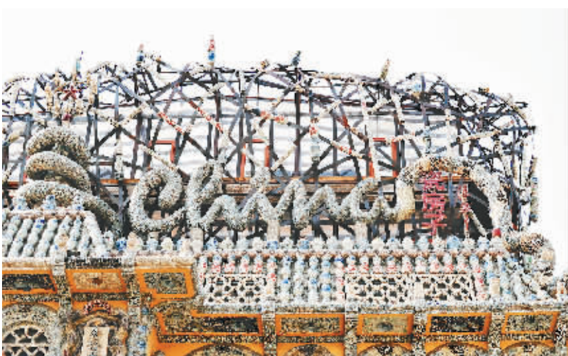
4月16日,天津“瓷房子”,中国古瓷博物馆顶部正在搭建钢板结构的“巢”,搭建完成后将以历代陶瓷瓷片进行装饰,与“瓷房子”融为一体。民间收藏家张连志历时6年精心打造的“瓷房子”是在一座法式洋楼建筑基础上,使用数亿片历代陶瓷瓷片装饰而成。新华社发
