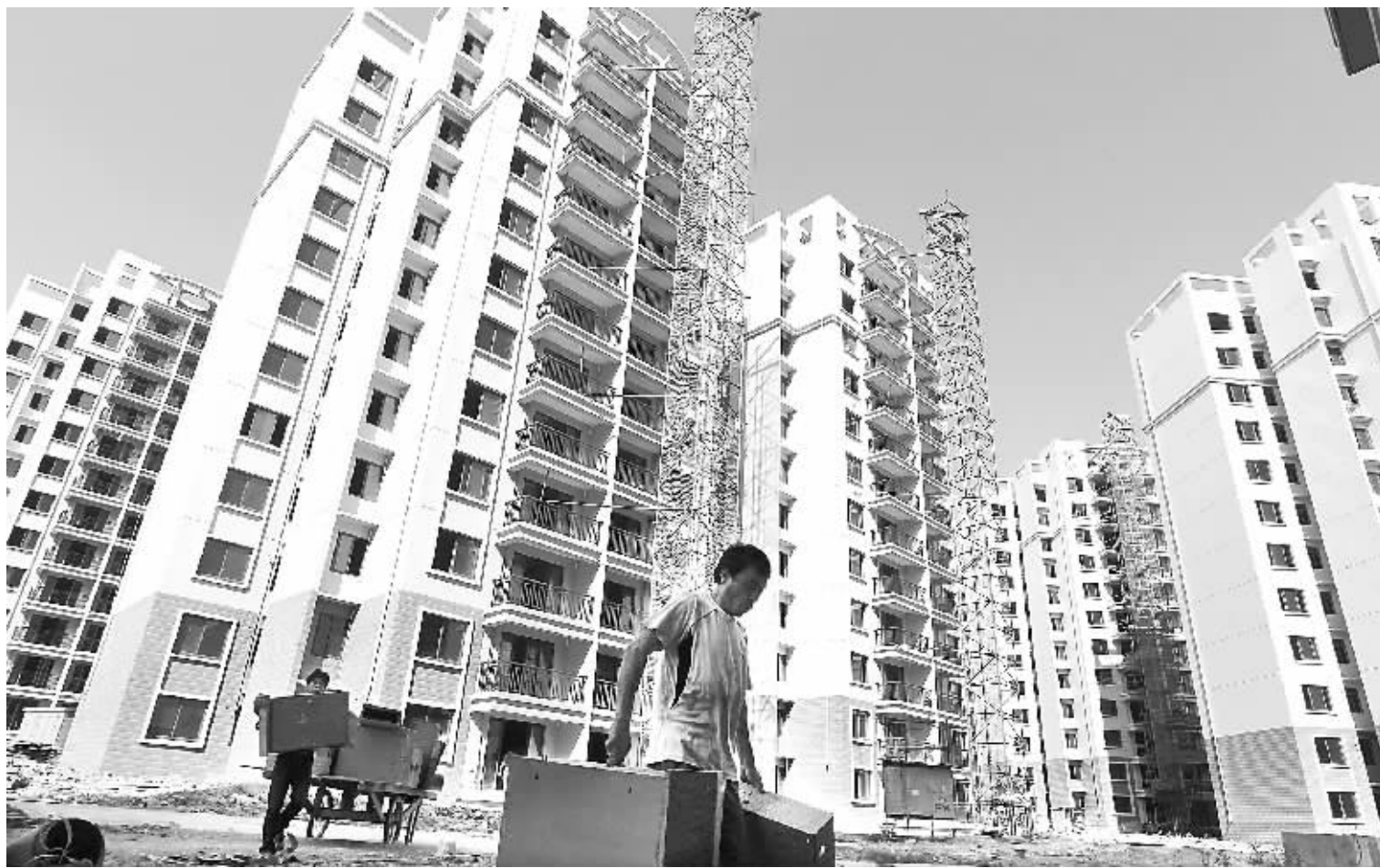
儋州市惠民工程怡心花园5052套保障性住房工程将于2012年5月竣工。
