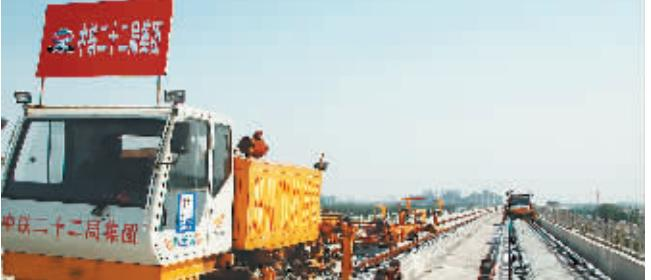
5月16日，工人操作机器在京石高铁铺轨施工现场施工。由中铁二十二局集团等单位负责施工的、全长280公里的北京至石家庄高铁工程进展顺利，将于6月份全线铺通。
