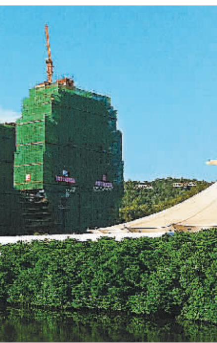
5月27日,施工中的三亚美丽之冠城市综合体项目。
